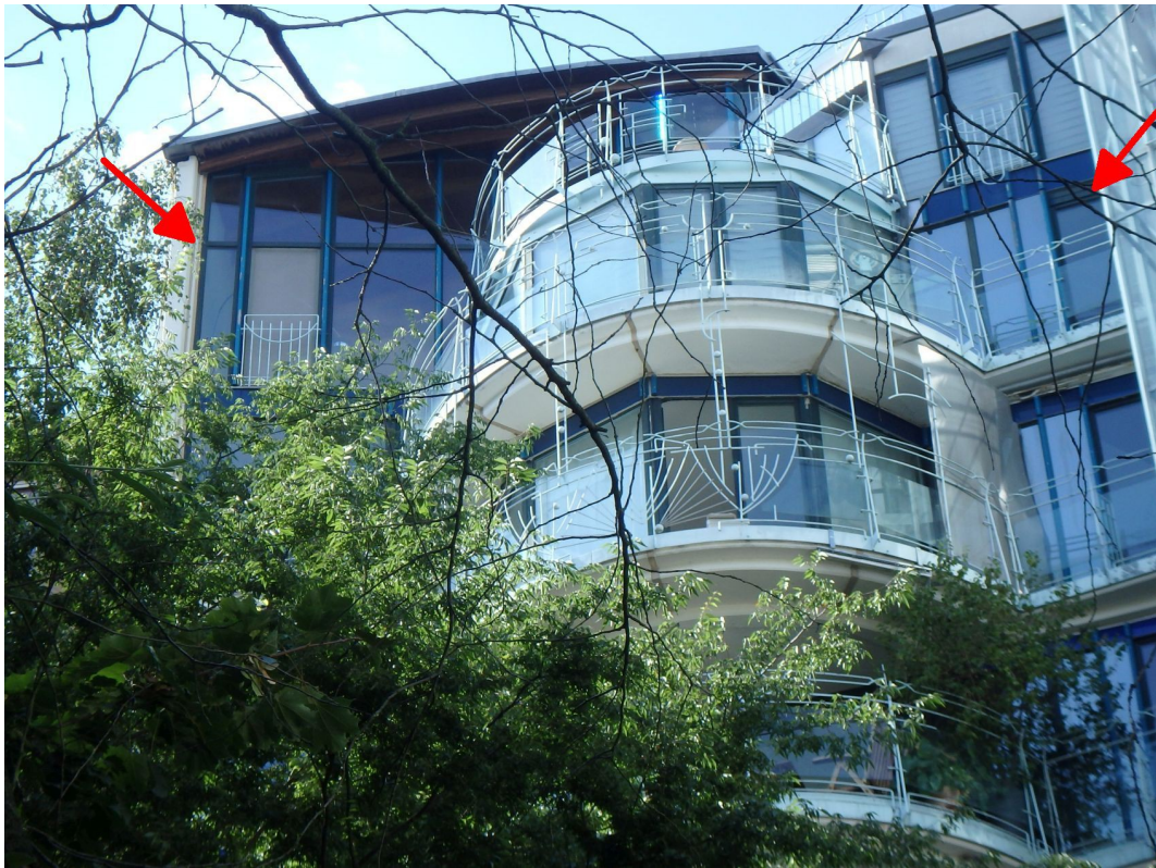
Wohn- und Geschäftshaus sowie Eigentumseinheit Nr. 26 Ostansicht
