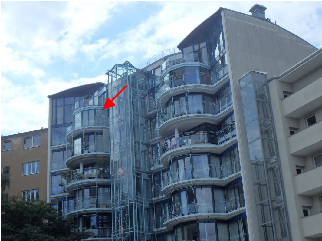
Wohn- und Geschäftshaus Nordostansicht
