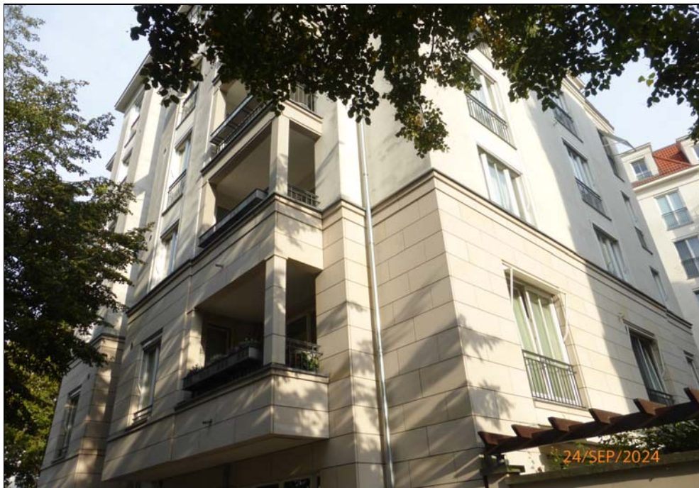
Straßenseitige Gebäudeansicht mit der betreffenden Wohnung Nr. 17
