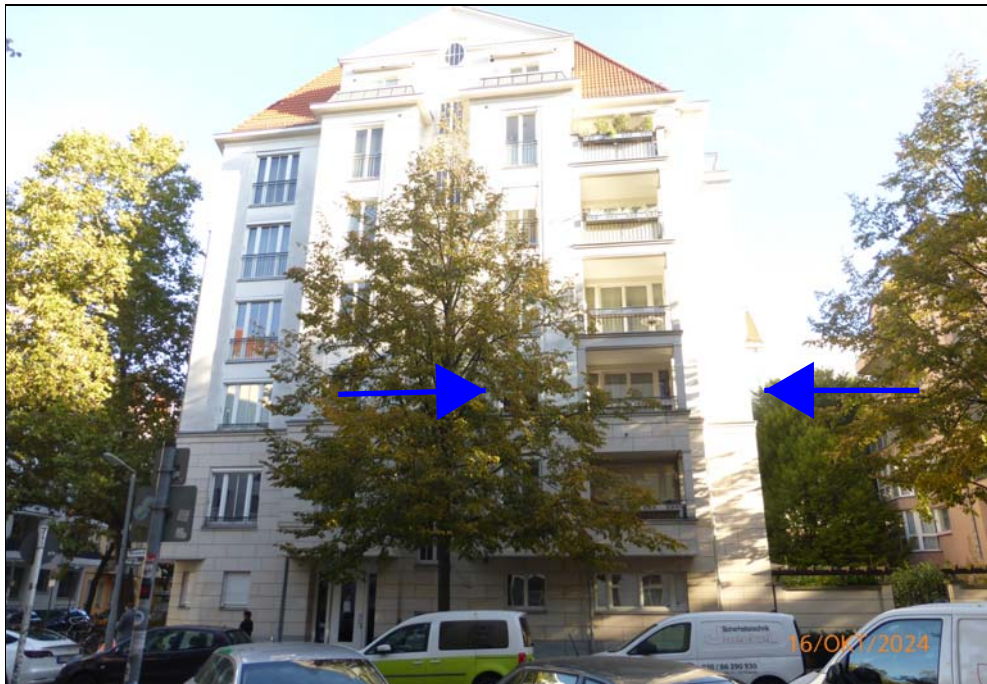
Straßenseitige Gebäudeansicht mit der betreffenden Wohnung Nr. 17
