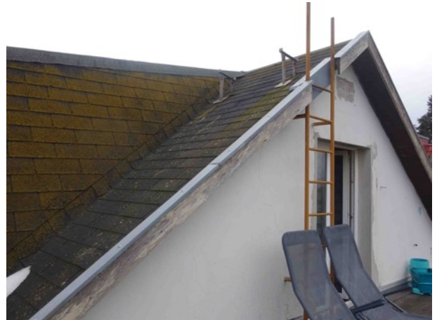
Abb. 15 EFH - Giebelansicht gartenseitig
