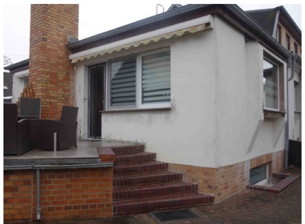
Abb. 13 Anbau EFH, Terrassenzugang
