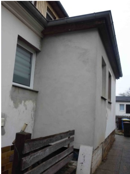
Abb. 10 EFH - südliche Seitenfassade (mit Anbau Hauseingang)
