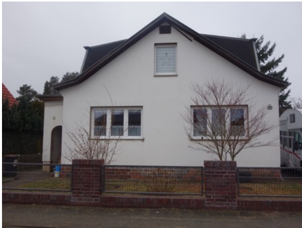
Abb. 8 Straßenansicht Einfamilienhaus (EFH)
