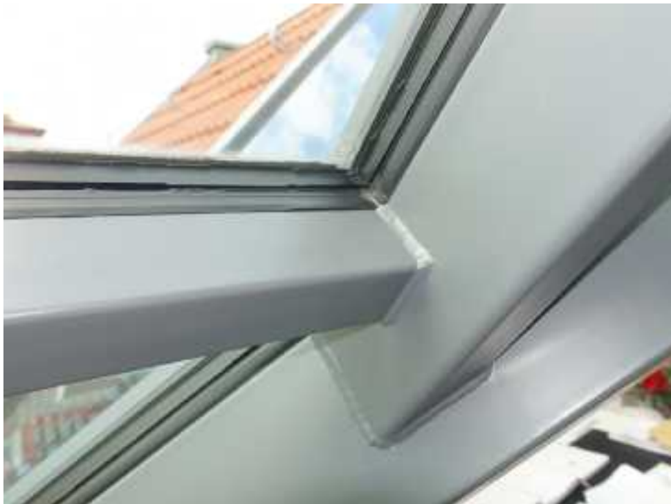
Detail der Schrägfassade Richtung Hof als Pfosten-Riegel-Konstruktion
