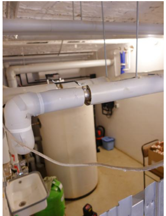
Übergaberaum der Fernwärme und Kessel für Warmwasser
