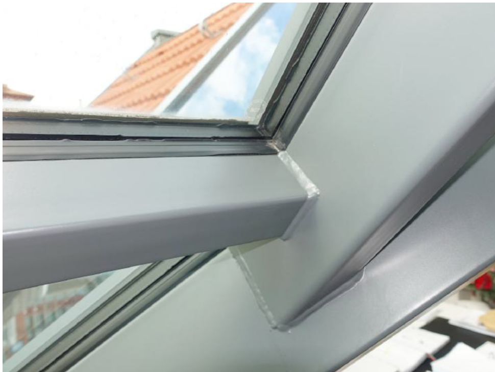
Detail der Schrägfassade Richtung Hof als Pfosten-Riegel-Konstruktion
