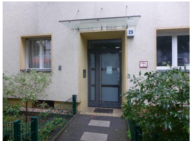
Hauseingang Jenaer Straße 29
