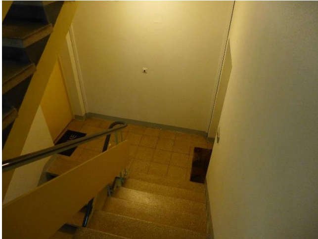
Treppenhaus Jenaer Straße 29
