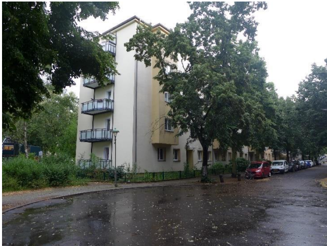
Straßenseitige Gebäudeansicht Jenaer Straße
