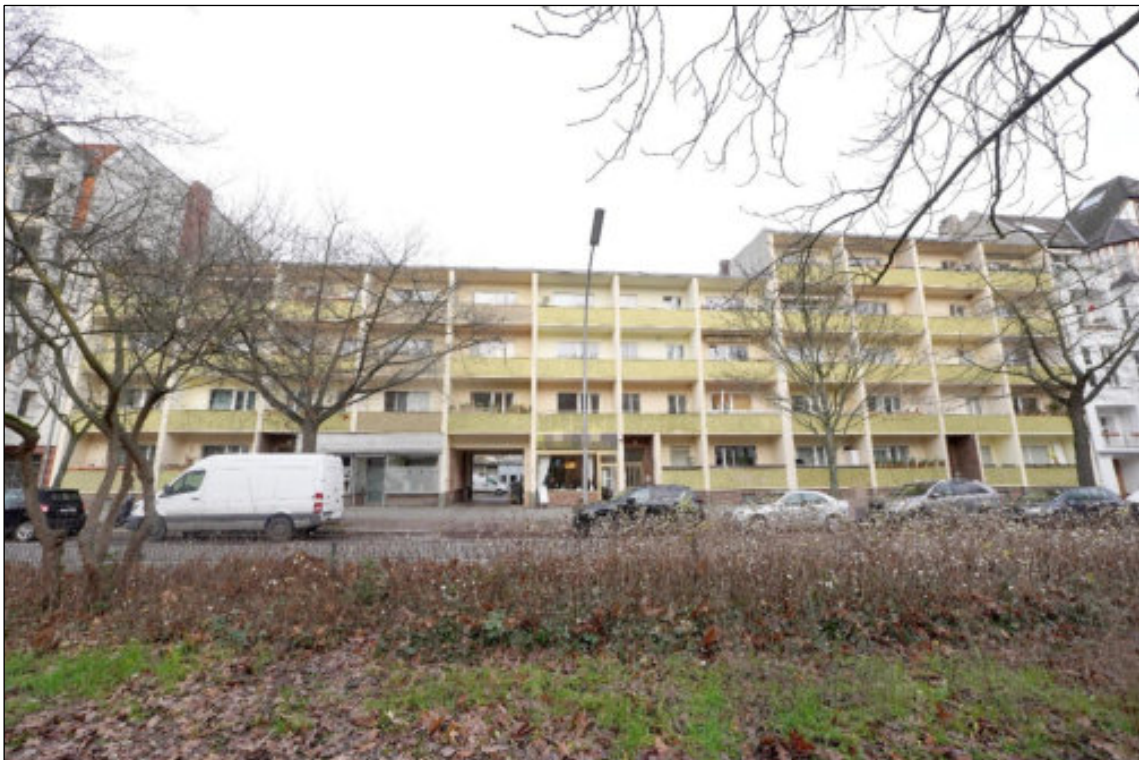
Neubau, Straßenansicht / Südansicht
