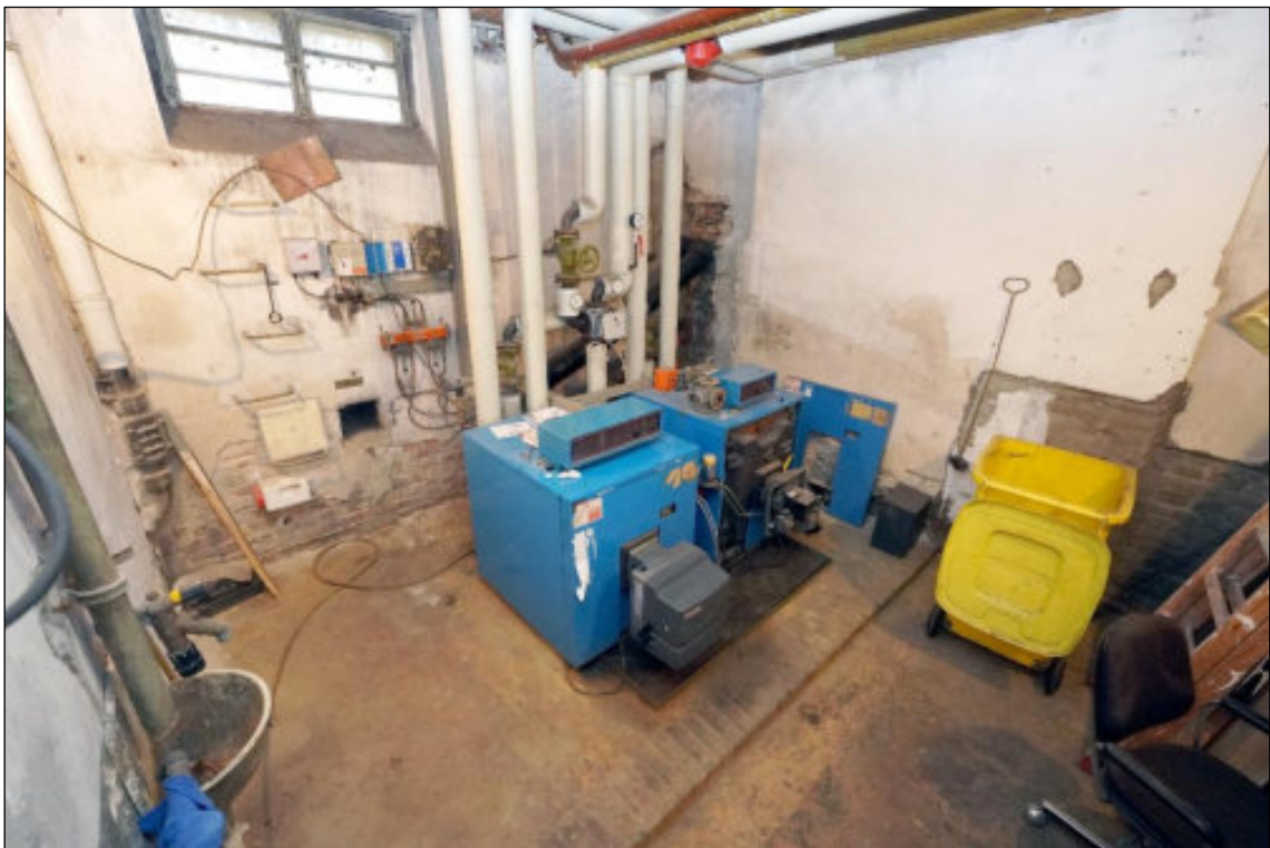
Neubau, Kellergeschoss / Heizung
