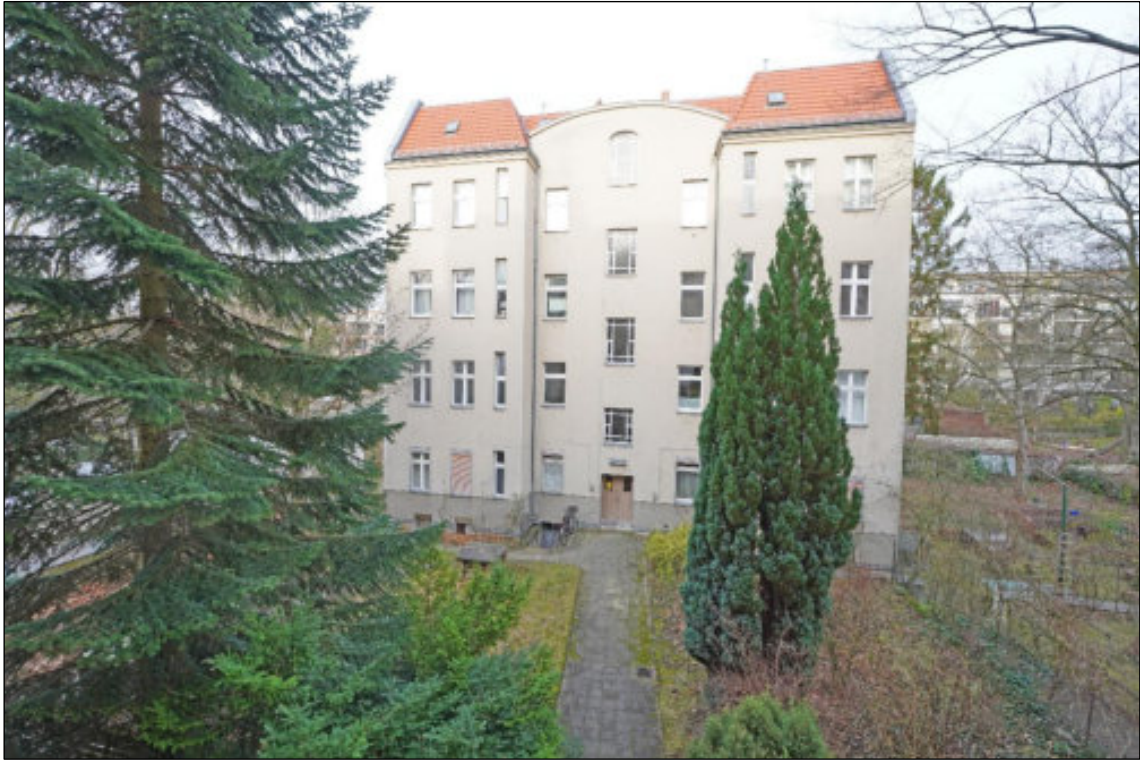
Altbau, Eingangsseite / Südansicht
