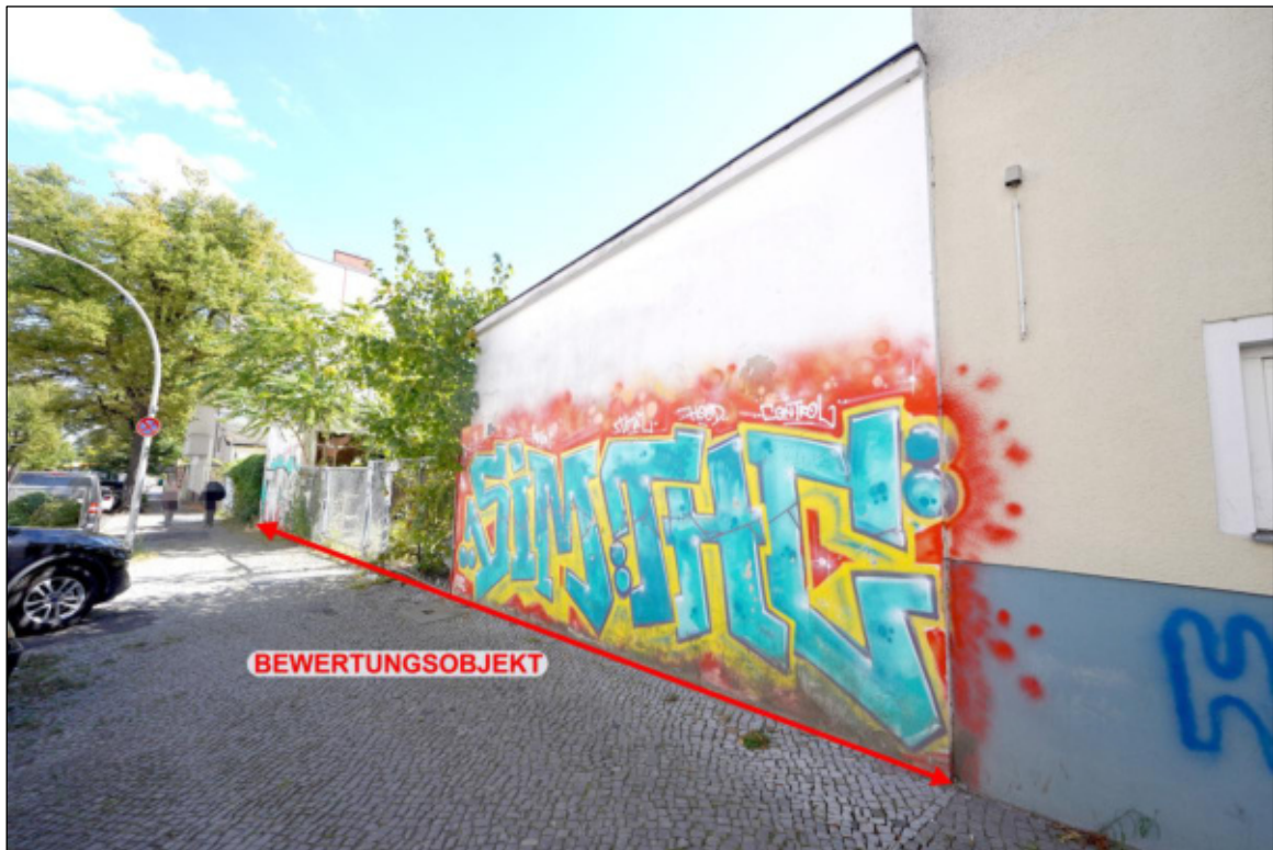
Blick entlang des Gehweges
