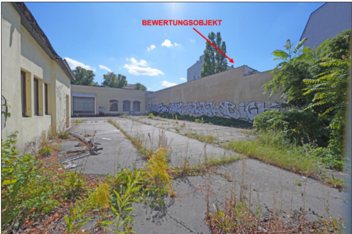
Blick vom linken Nachbargrundstück auf die Giebelwand der Garagenzeile
