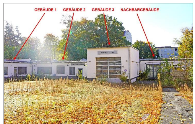
Gebäude Nr. 1 – 3 und Nachbarbebauung
