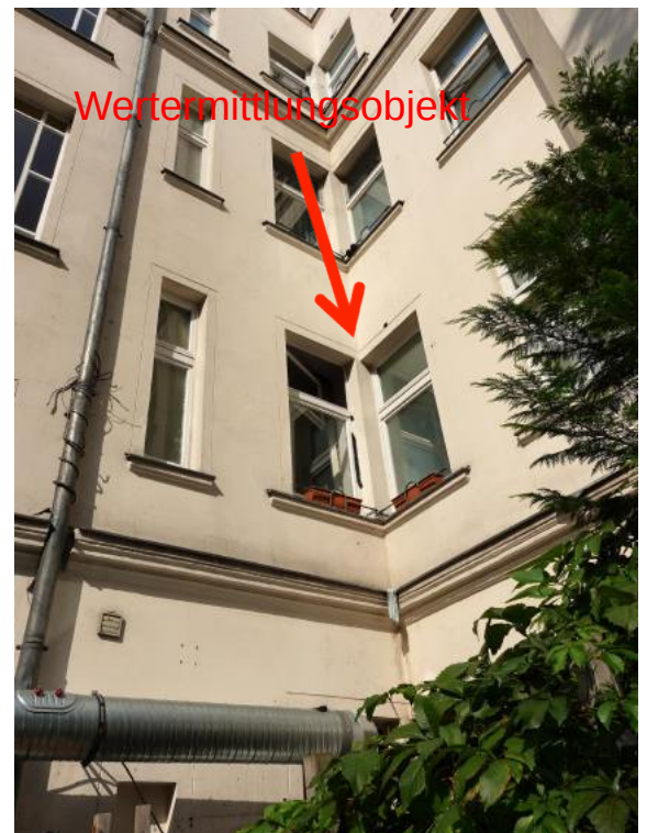
Hoffassade; die Lage der WE 5 ist markiert
