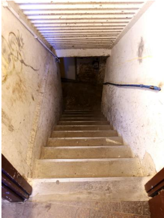
Abgang in den Keller im Vorderhaus
