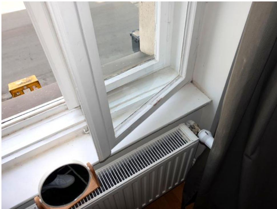
Detail, Fenster und Heizung
