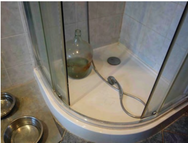
Abb. 42 Dusche Wohnung 2 (1. OG)
