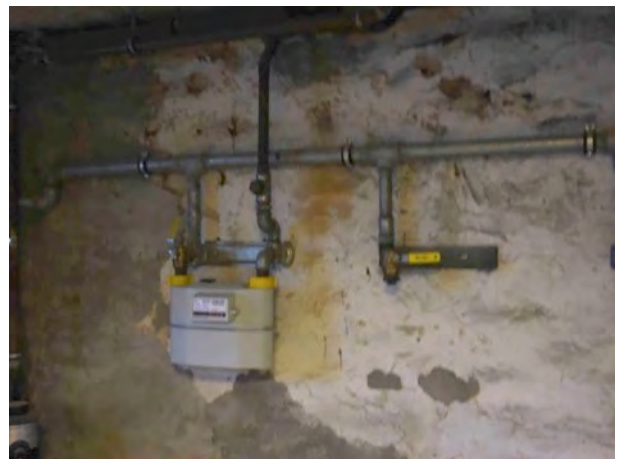
Abb. 21 Gasanschluss
