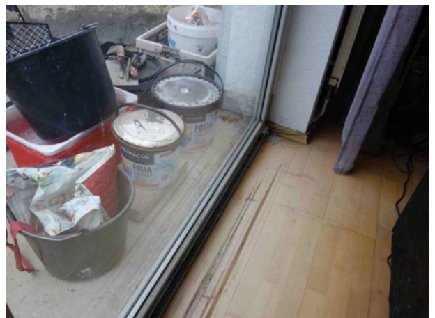
Abb. 39 Schwelle zu Balkon Wohnung 2 (1. OG), Schiebetür
