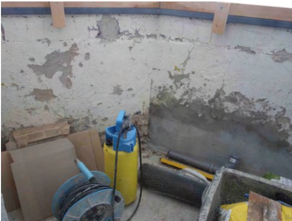
Abb. 40 Balkonbrüstung Wohnung 2 (1. OG)
