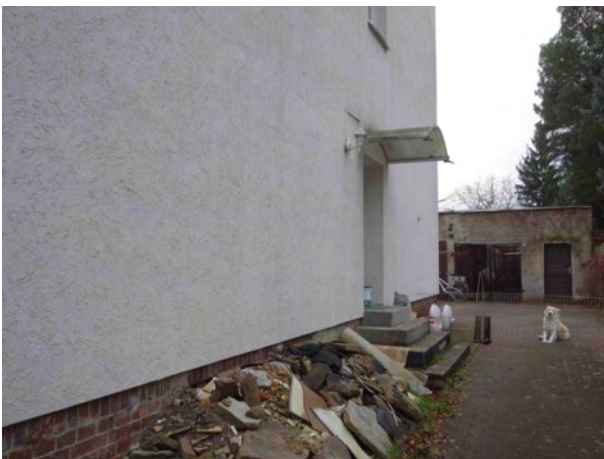
Abb. 12 Zufahrt und Hauseingang
