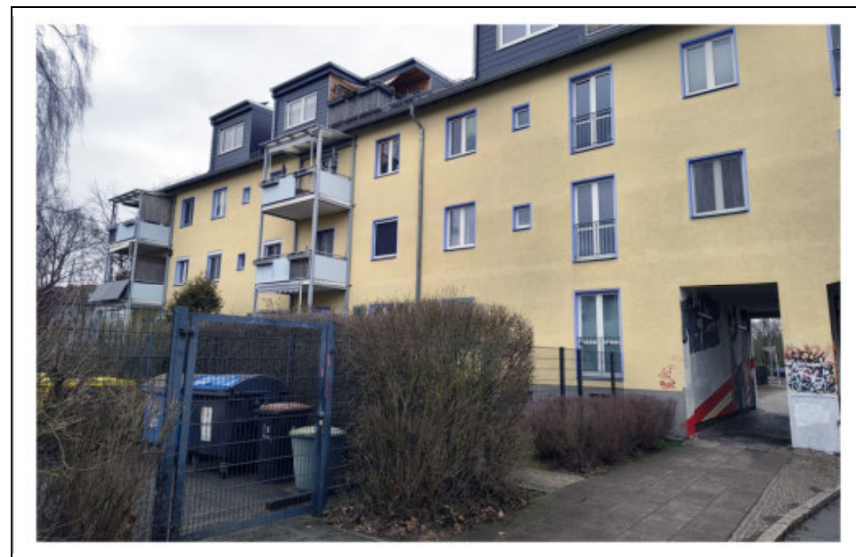
Bild 12 o Ansicht vom Mülltonnenabstellplatz
