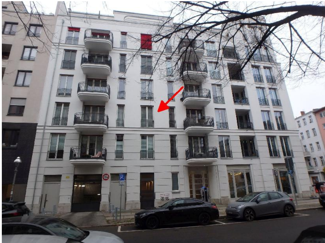
Wohn- und Geschäftshausblock (Aufgang Rückertstraße 7) Westansicht (Straßenansicht)
