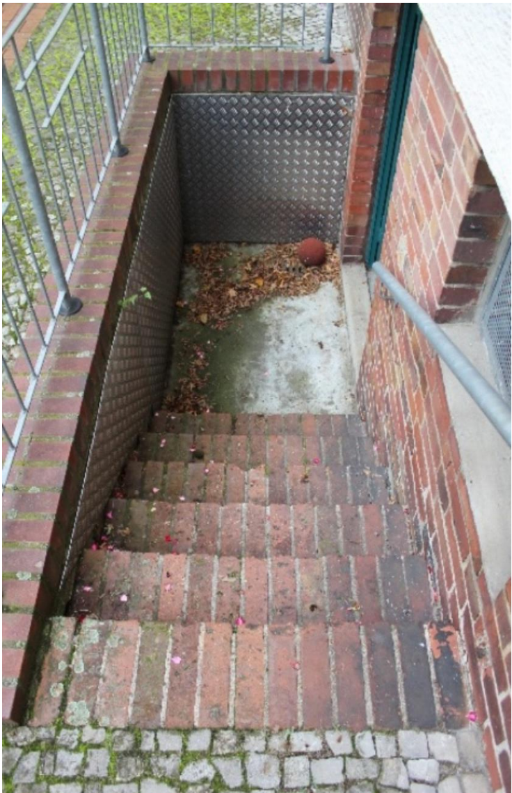
Treppe zum Innenhof
