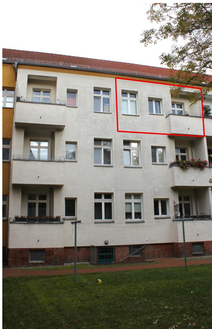
Gebäuderückseite, rote Markierung: Wohnung Nr. 47 rot umrandet
