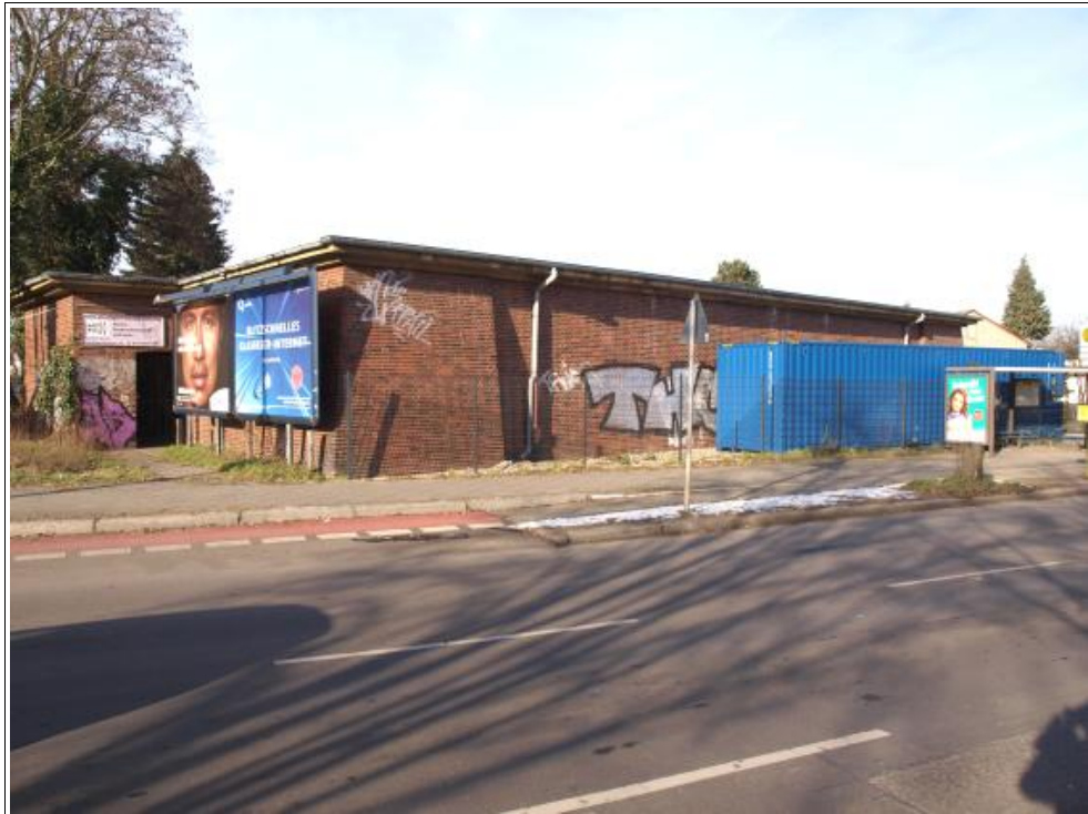
Abbildung 5: Straßenansicht (Johannisthaler Chaussee) aus Richtung Süden
