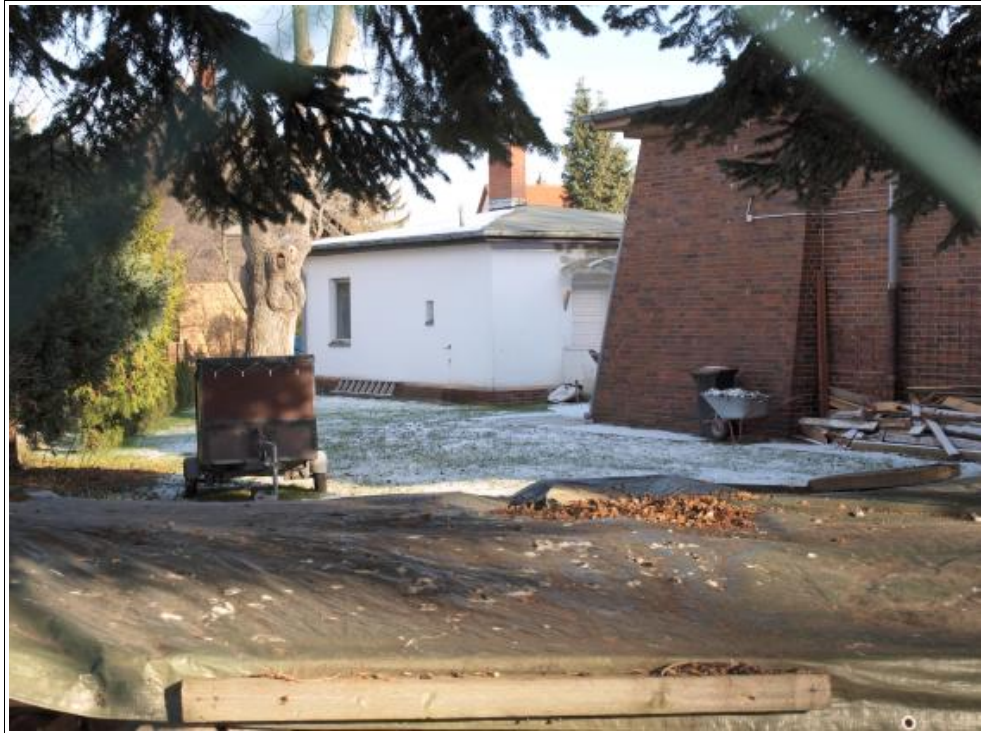
Abbildung 9: seitliche Ansicht am Steinträgerweg aus Richtung Westen, im Hintergrund ein zusätzliches Nebengebäude (Bungalow)
