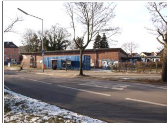
Straßenansicht (Johannisthaler Chaussee) aus Richtung Südost
