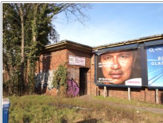
Eingangsbereich an der Johannisthaler Chaussee
