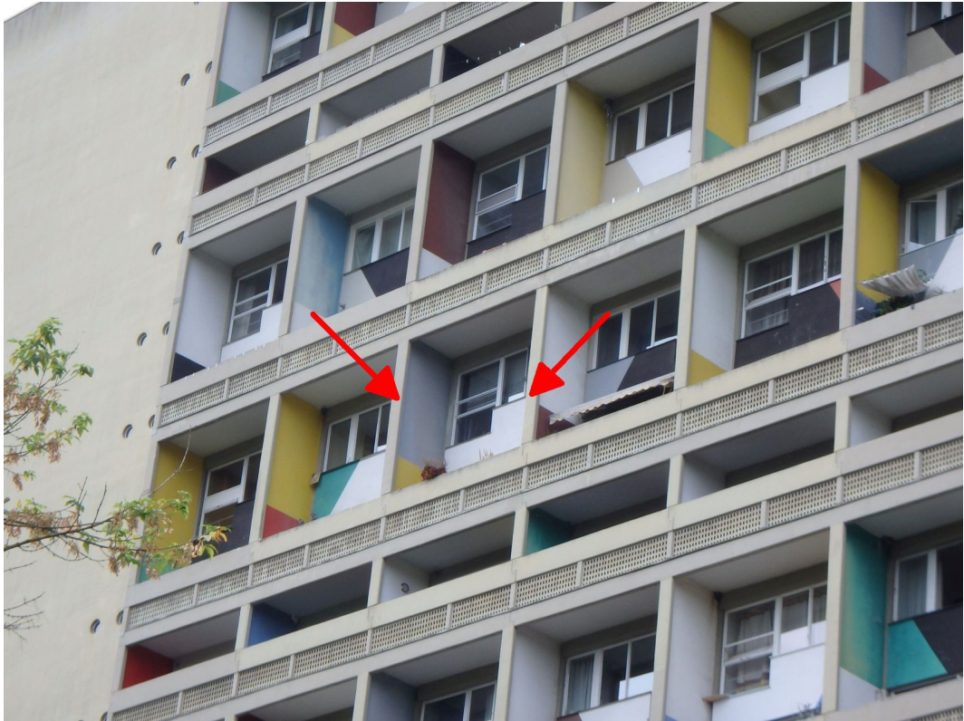
Wohn- und Geschäftshaus sowie Eigentumseinheit Nr. 748 Nordostansicht
