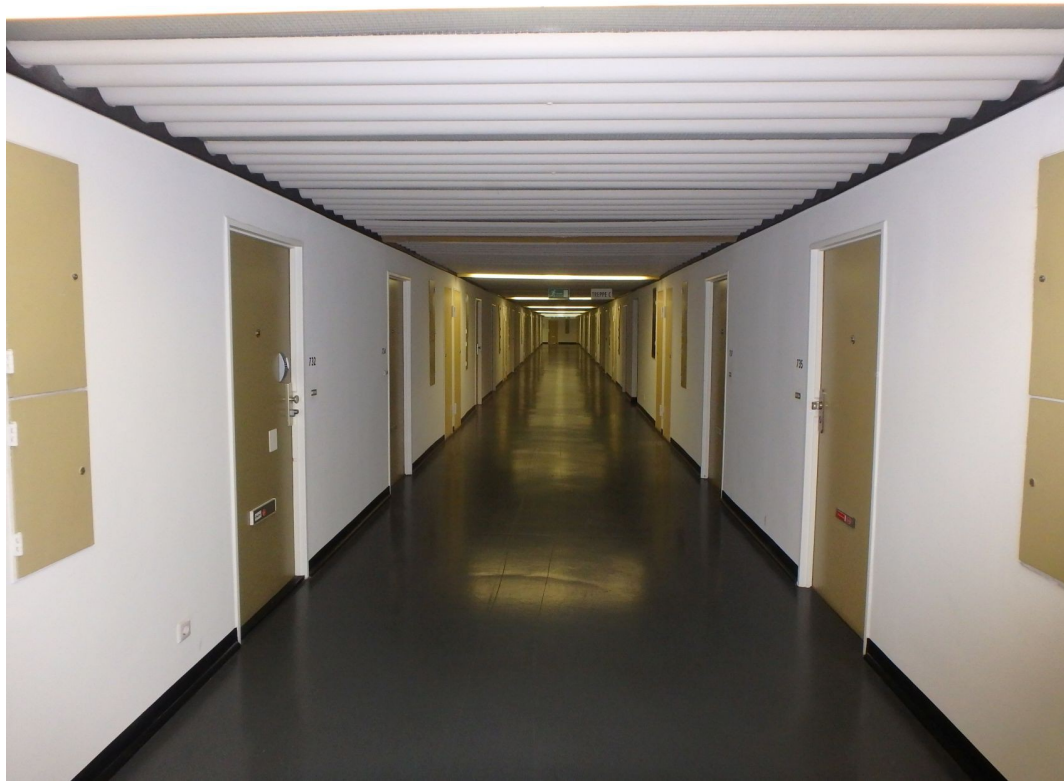
Innenansicht Erschließungsflur (Innenstraße)
