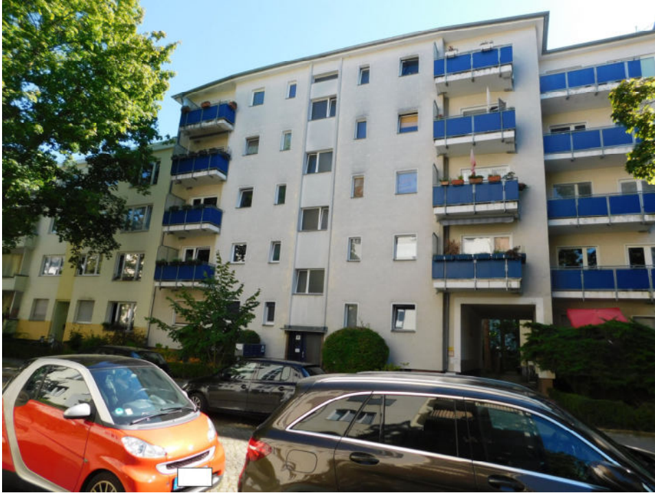
Orber Straße 2 in 14193 Berlin-Schmargendorf WE Nr. 7 im 1. Obergeschoss - Gebäudeansichten -
