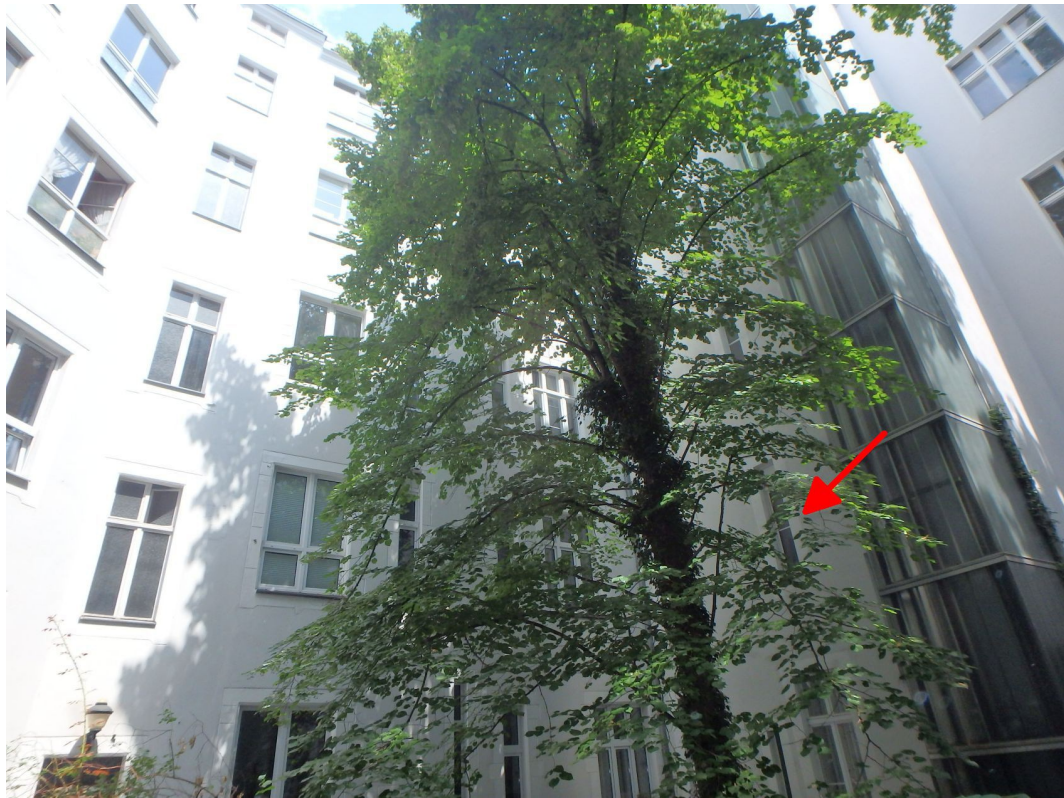
Mehrfamilienwohnhaus (Aufgang Joachim-Friedrich-Straße 56) Südwestansicht (Hofansicht)
