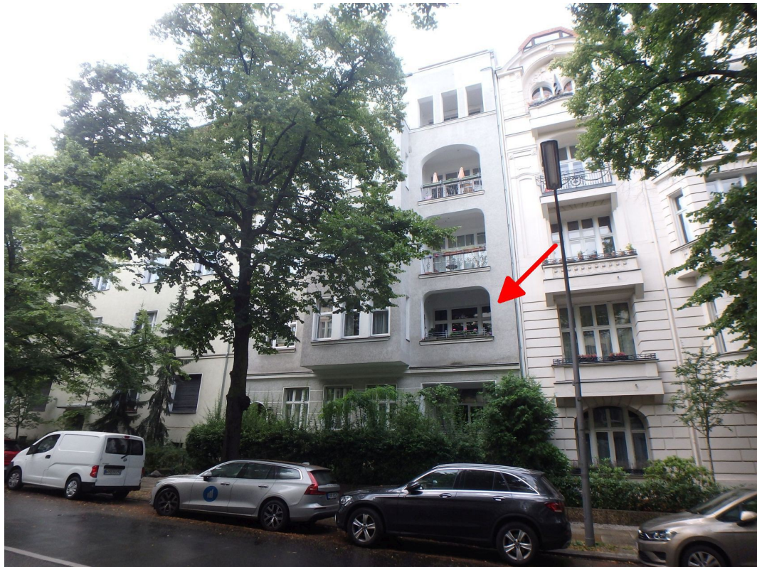
Mehrfamilienwohnhaus (Aufgang Joachim-Friedrich-Straße 56) Nordostansicht (Straßenansicht)
