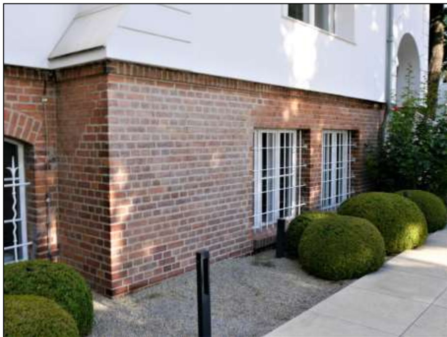
süd-östliche Giebelseite des auf dem Grundstück Spreetalallee 1, Spandauer Damm 212 (Flurstück 676) aufstehenden Wohn- und Geschäftshauses im Bereich des Souterrains
