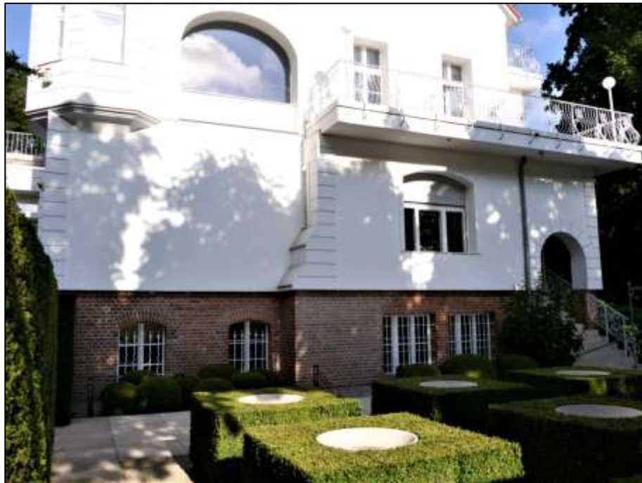
süd-östliche Giebelseite des auf dem Grundstück Spreetalallee 1, Spandauer Damm 212 (Flurstück 676) aufstehenden Wohn- und Geschäftshauses im Bereich des Souterrains und des Hochparterres mit separatem Rundbogen-Eingang zum Hochparterre
