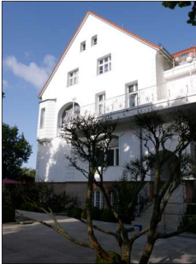
süd-östliche Giebelseite des auf dem Grundstück Spreetalallee 1, Spandauer Damm 212 (Flurstück 676) aufstehenden Wohn- und Geschäftshauses
