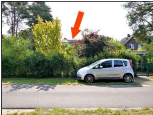
straßenseitige Gebäudefront (Pfeil)
