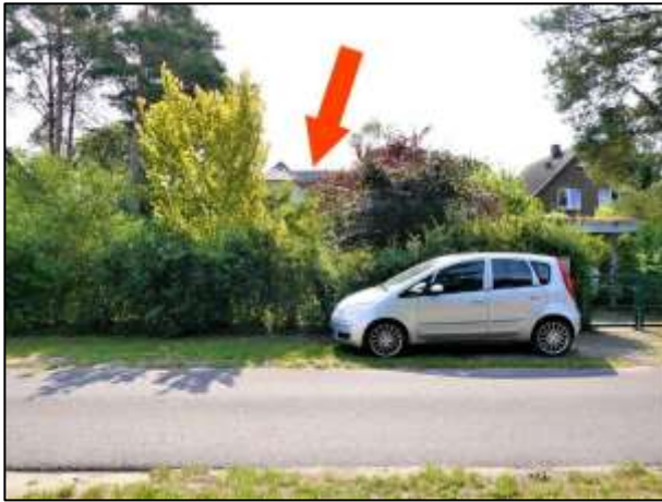
straßenseitige Gebäudefront (Pfeil)
