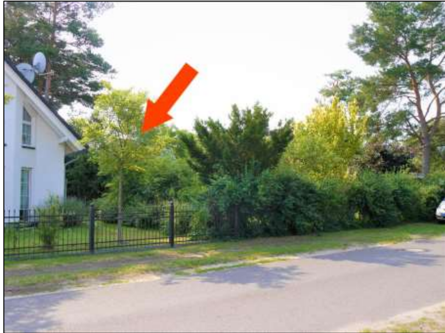
Blick aus dem Beiersdorfer Weg nach Süd-Osten über das Nachbargrundstück Beiersdorfer Weg 27 (Flurstück 842) hinweg auf das auf dem hier betroffenen Grundstücks Beiersdorfer Weg 29 (Flurstück 205) aufstehende Einfamilienhaus (Pfeil)
