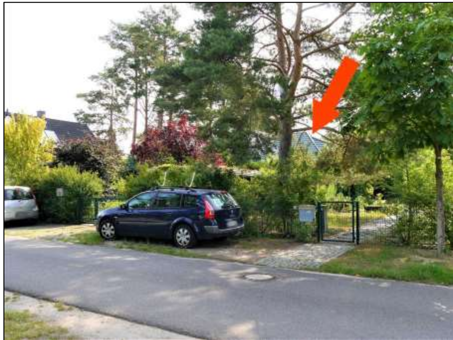
Blick aus dem Beiersdorfer Weg nach Osten über das Nachbargrundstück Beiersdorfer Weg 31 (Flurstück 206) hinweg auf das auf dem hier betroffenen Grundstücks Beiersdorfer Weg 29 (Flurstück 205) aufstehende Einfamilienhaus (Pfeil)
