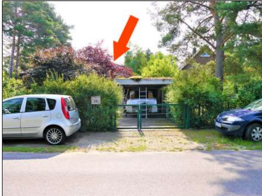
Blick aus dem Beiersdorfer Weg auf die straßenseitige Front des Grundstück Beiersdorfer Weg 29 (Flurstück 205) im Bereich der Grundstücksauffahrt und der Toranlage mit Schlupfpforte zur Hauszuwegung sowie Lage des aufstehenden Einfamilienhauses im Hintergrund (Pfeil)
