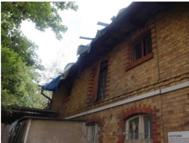
Abb. 18 Fassade Remise mit Dachboden
