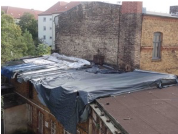
Abb. 20 Dachaufsicht Remise mit provisorischer Folien-Abdeckung
