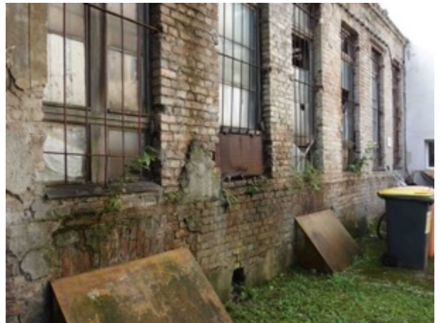
Abb. 13 unterkellerte Teil der Remise (Anbau an Vorderhaus)
