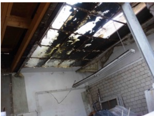
Abb. 26 Blick durchs Fenster auf leichte Dachkonstruktion des Anbaus (unterkellert Bereich der Remise)
