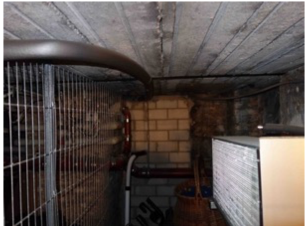
Abb. 23 zugemauerte Verbindung zwischen KG Vorderhaus und KG zu Teileigentum Nr. 9
