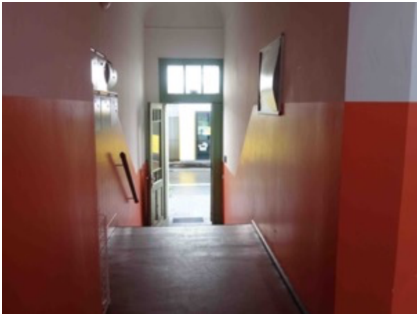
Abb. 22 Hausdurchgang (Zugang zur Remise)
