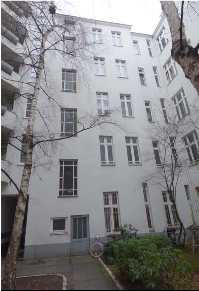
rückwärtige Ansicht Paretzer Straße
