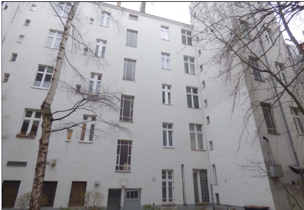
rückwärtige Ansicht Blissestraße
