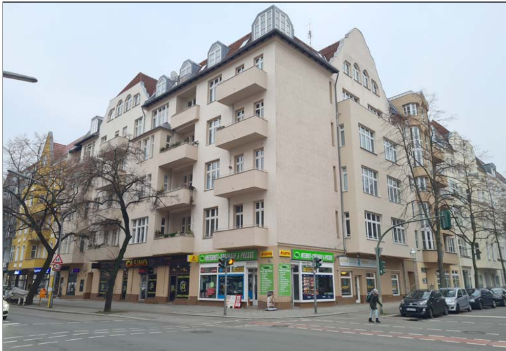
Straßenseitige Gebäudeansicht Ecksituation
