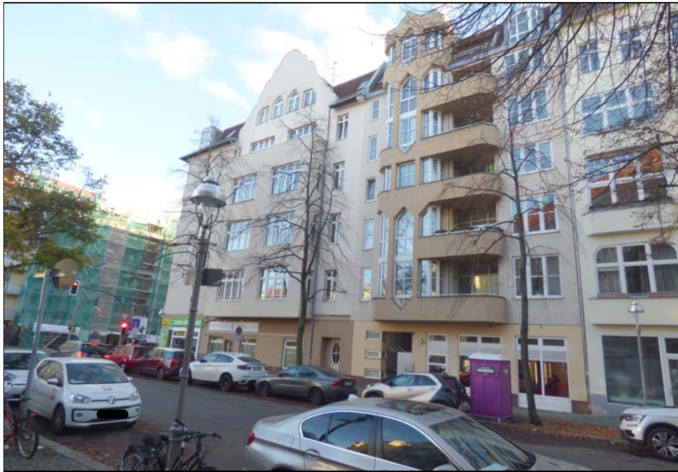
Gebäudeteil Paretzer Straße
