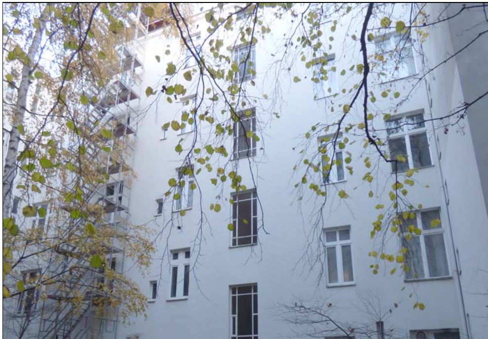
rückwärtige Ansicht Blissestraße
