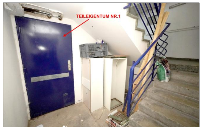
Zugangstür im Kellergeschoss
