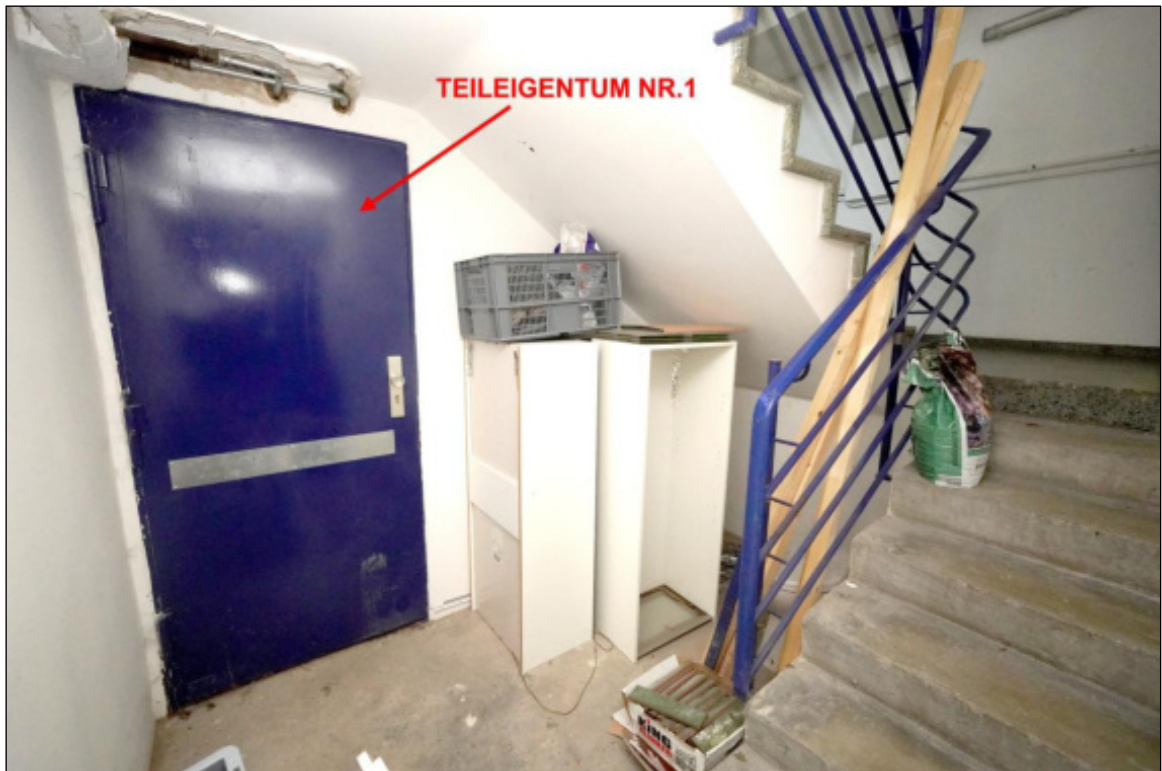
Eingangstür im Kellergeschoss
