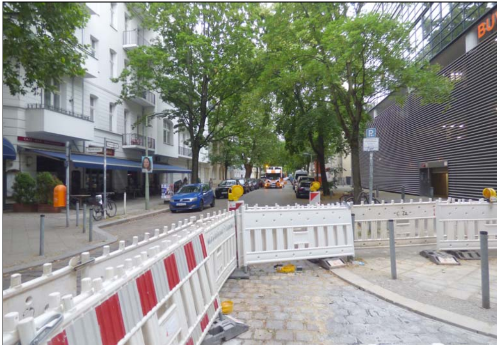
Blick in die Eislebener Straße
