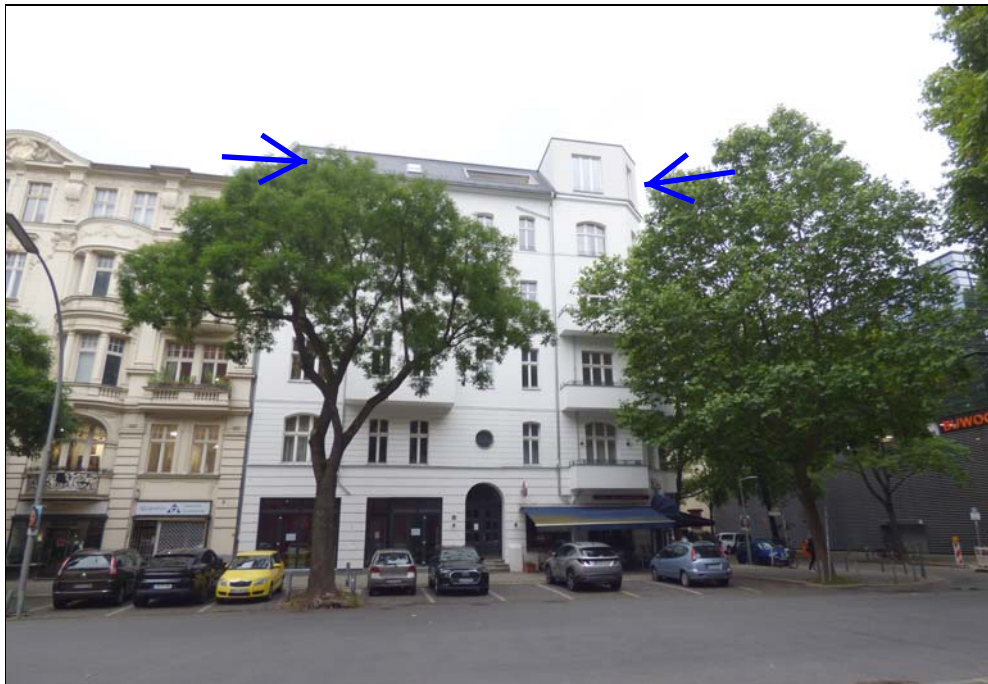
Gebäudeteil Eislebener Straße 10 mit der betreffenden Wohnung Nr. 28
