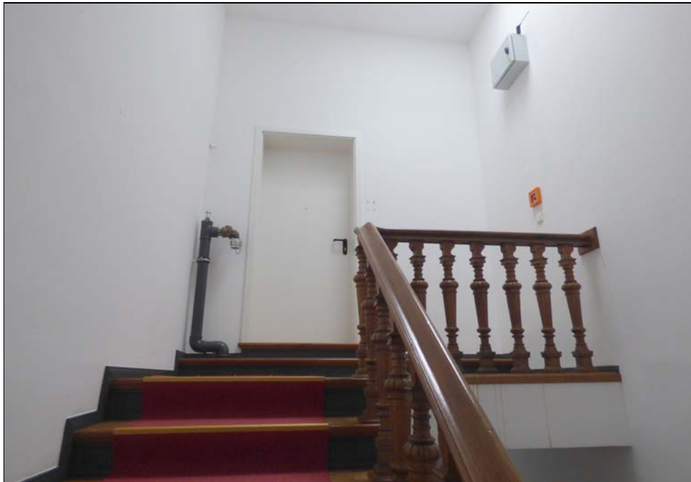
Zugang zur Wohnung Nr. 28
