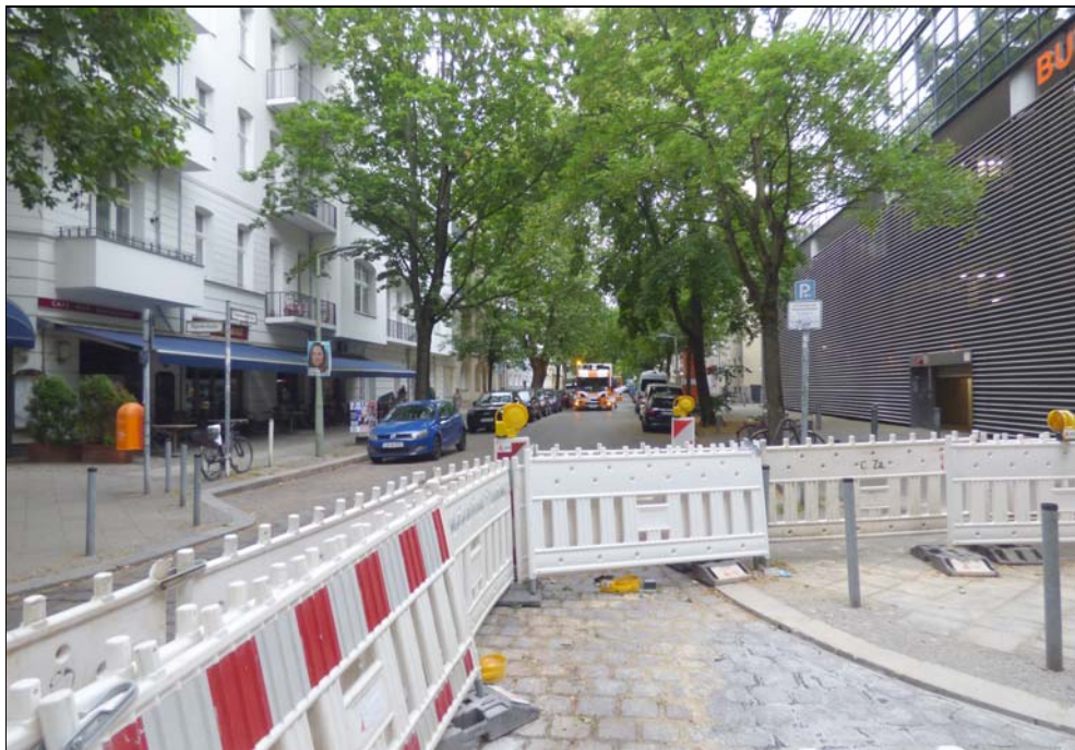
Blick in die Eislebener Straße
