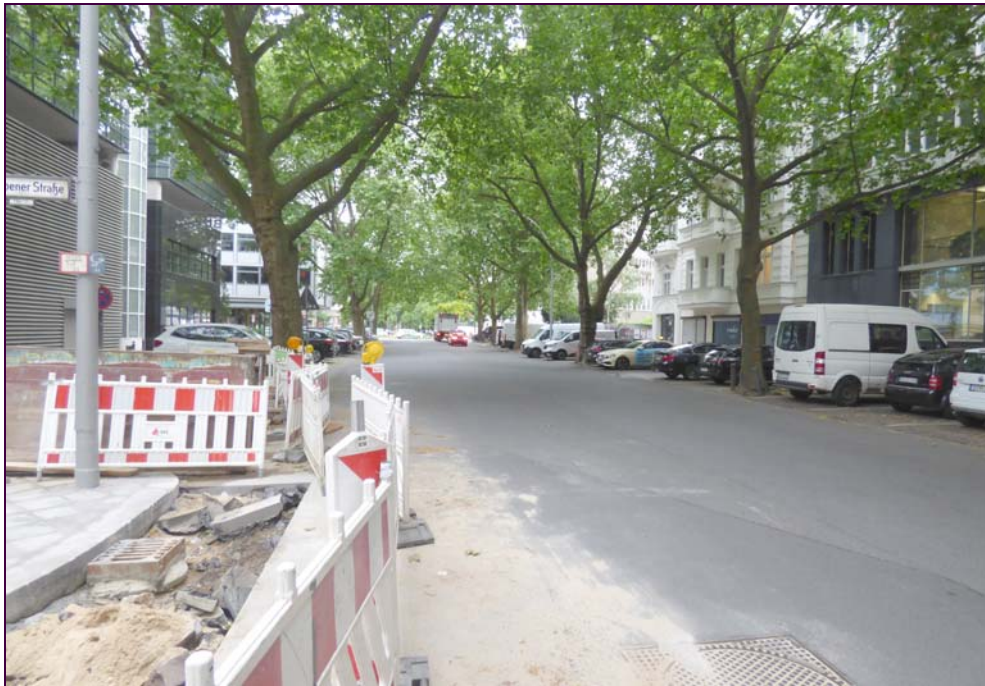
Rankestraße im Objektbereich
