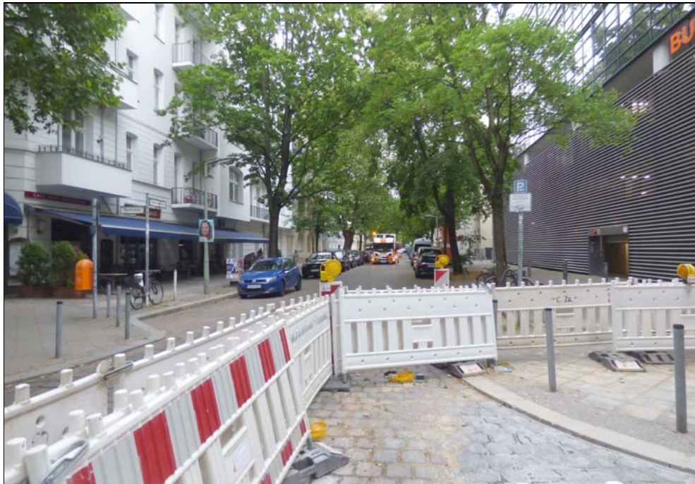
Blick in die Eislebener Straße
