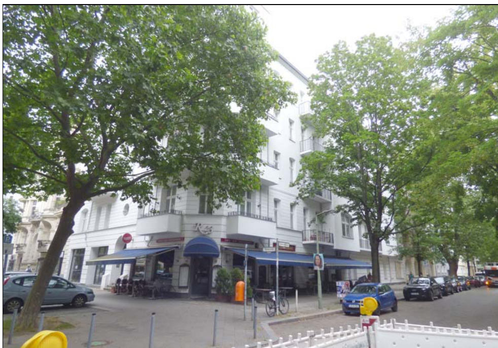
Straßenseitige Gebäudeansicht Ecksituation
