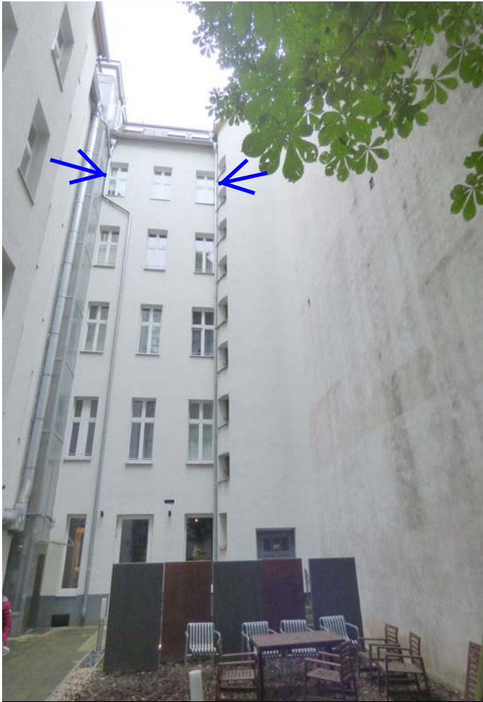
rückwärtige Gebäudeansicht mit der betreffenden Wohnung Nr. 25
