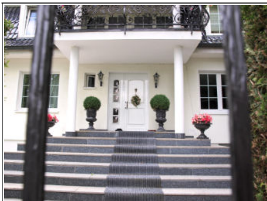
straßenseitige Ansicht aus Richtung Nordost
