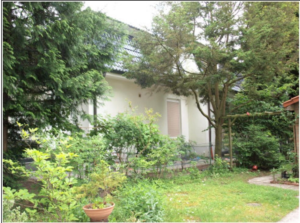
Abbildung 12: seitliche Ansicht aus Richtung Norden
