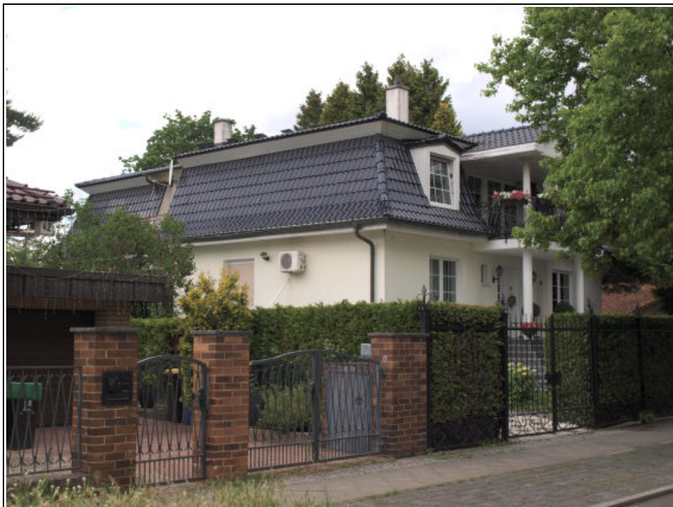
Abbildung 10: seitliche, straßenseitige Ansicht aus Richtung Osten
