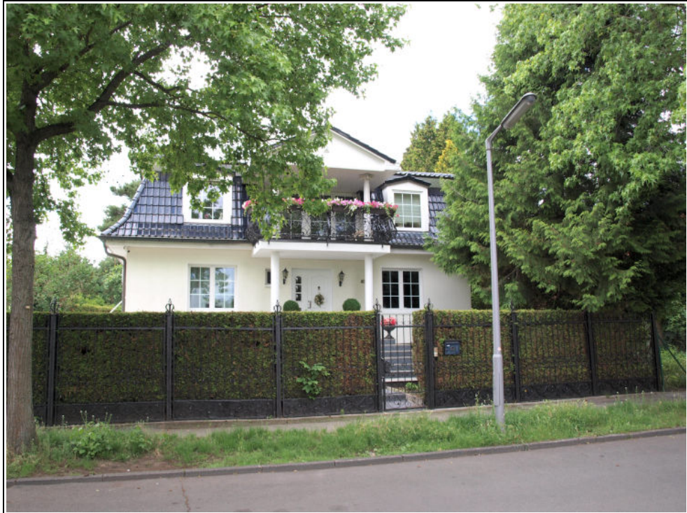
Abbildung 8: straßenseitige Ansicht aus Richtung Nordost
