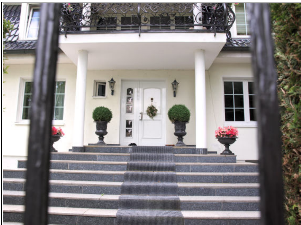
Abbildung 9: straßenseitige Ansicht aus Richtung Nordost
