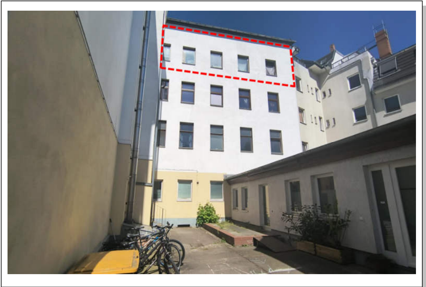
Bild 9 o Links: Rückansicht vom Mehrfamilienhaus, die Lage der Wohnung 13 wurde markiert
