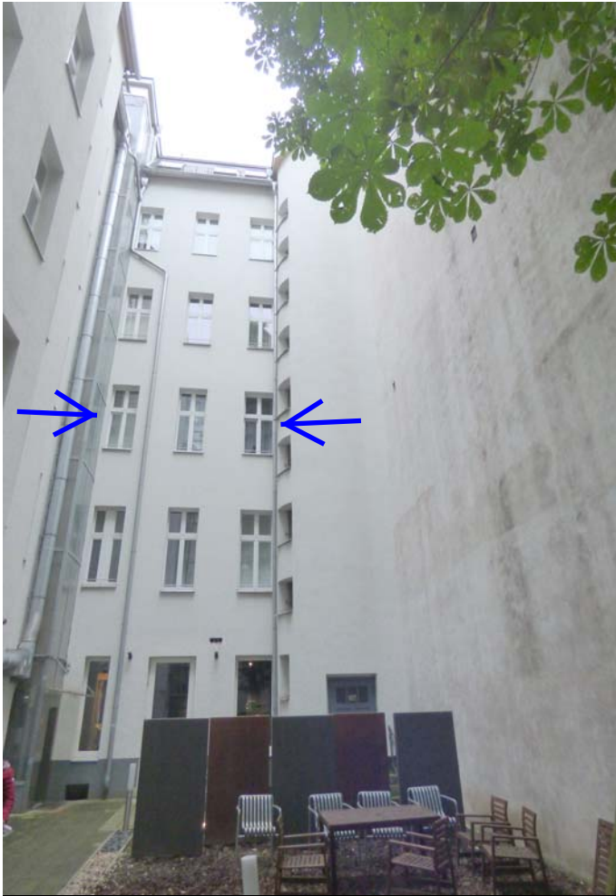
rückwärtige Gebäudeansicht mit der betreffenden Wohnung Nr. 16
