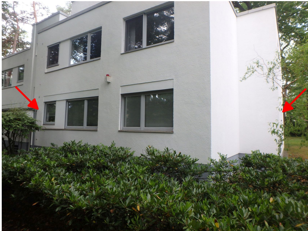
Mehrfamilienwohnhaus (Dünkelbergsteig 6) sowie Eigentumseinheit Nr. 4.1 Nordostansicht
