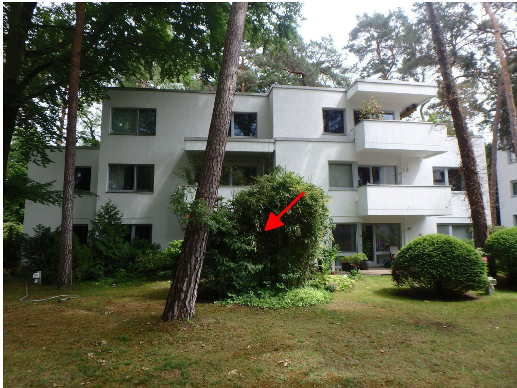
Mehrfamilienwohnhaus (Dünkelbergsteig 6) Westansicht
