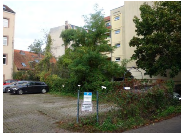
Abb. 20 Blick von Gartenstraße zum Wohnhaus (im Vordergrund benachbarter Parkplatz)
