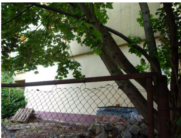
Abb. 25 Giebelwand des nördlich an Flurstück 339 angrenzenden Mehrfamilienhauses (Überbau)
