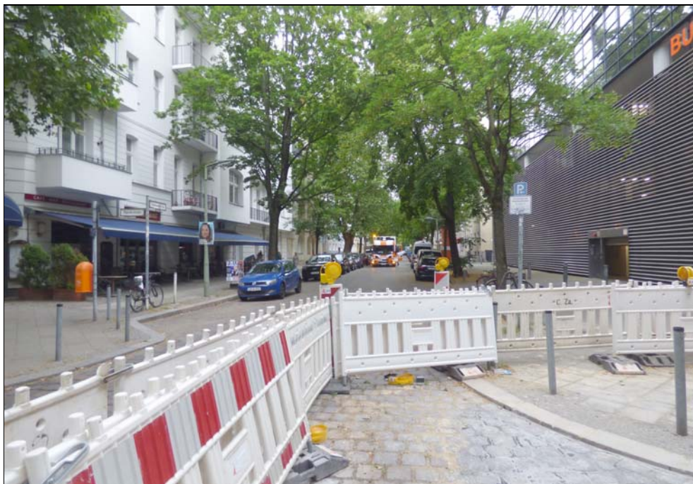
Blick in die Eislebener Straße
