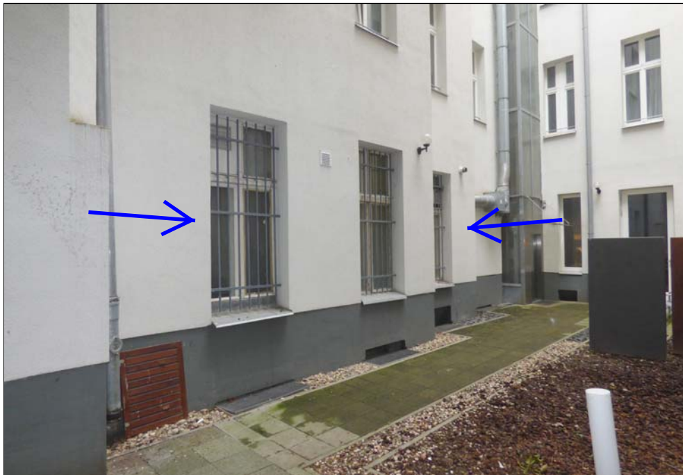
rückwärtige Gebäudeansicht mit dem betreffenden Teileigentum Nr. 3
