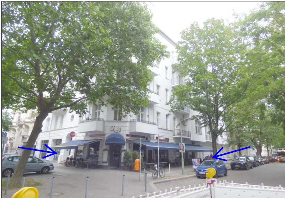
Straßenseitige Gebäudeansicht Ecksituation mit dem betreffenden Teileigentum Nr. 3
