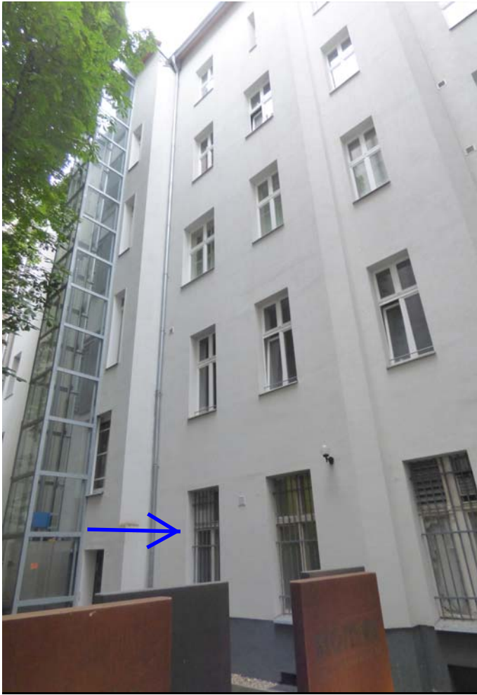
rückwärtige Gebäudeansicht mit dem betreffenden Teileigentum Nr. 3
