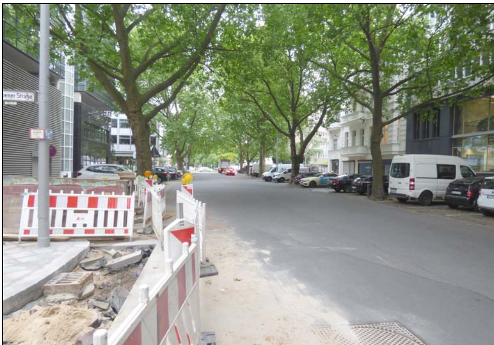
Rankestraße im Objektbereich
