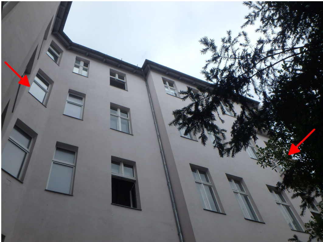
Wohn- und Geschäftshaus (Quergebäude) sowie Eigentumseinheit Nr. 16 Ostansicht (Hofansicht)
