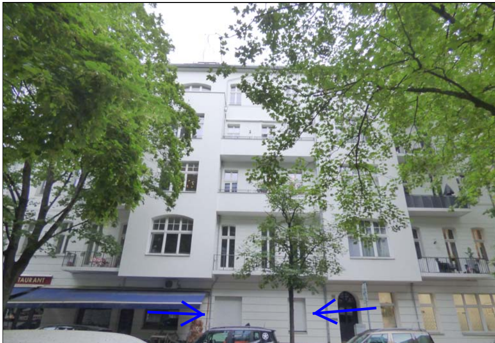
Gebäudeteil Eislebener Straße 10 mit dem betreffenden Teileigentum Nr. 2a
