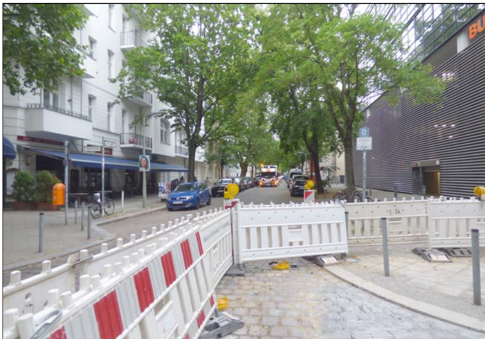
Blick in die Eislebener Straße
