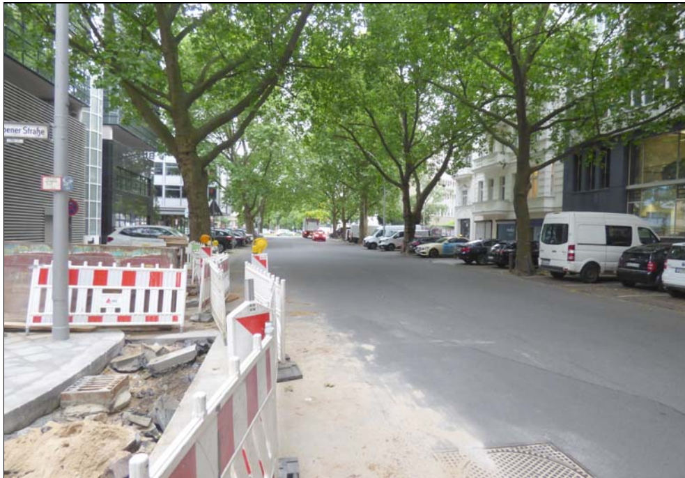
Rankestraße im Objektbereich
