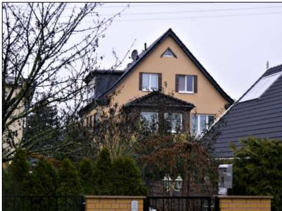
Blick aus dem Späthsfelder Weg nach Westen mit Lage des auf dem Grundstück Alpenrosenweg 52 aufstehenden Wohngebäudes und Kabeltrasse im Luftraumprofil über dem süd-westlich angrenzenden Nachbargrundstück
