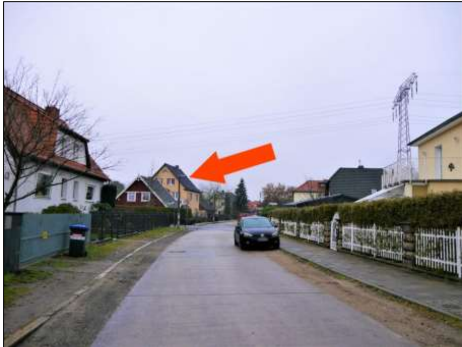
Blick über den Kreuzungsbereich Späthsfelder Weg/Alpenrosenweg in den Alpenrosenweg nach Westen mit Lage des Grundstücks Alpenrosenweg 52 auf der süd-westlichen bzw. im Bild linken Straßenseite (Pfeil) und T-Mast einer 220 kV-Hochspannungsleitung auf einem Nachbargrundstück schräg gegenüber dem Bewertungsobjekt
