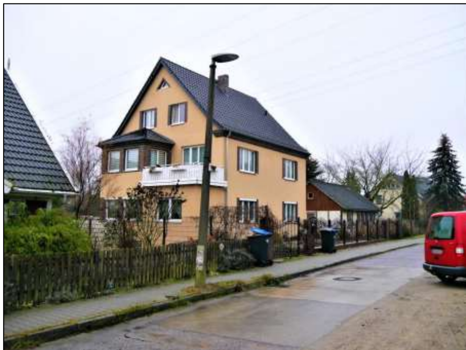
Blick aus dem Alpenrosenweg nach Westen auf das Grundstück Alpenrosenweg 52 auf der süd-westlichen Straßenseite und unmittelbar hinter dem Bewertungsobjekt verlaufender Hochspannungstrasse mit im Luftraumprofil verspannten Starkstromkabeln
