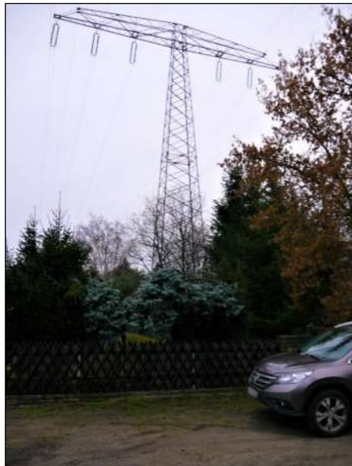
Blick aus dem Alpenrosenweg nach Nord-Osten mit Lage des T-Mastes einer 220 kV-Hochspannungsleitung auf einem schräg gegenüber dem Bewertungsobjekt Alpenrosenweg 52 belegenen Nachbargrundstück
