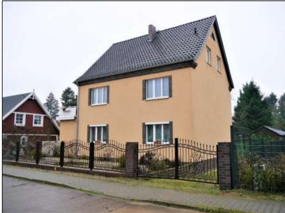
straßenseitige Front und nord-westliche Giebelseite des auf dem Grundstück Alpenrosenweg 52 aufstehenden Wohngebäudes mit Belastung durch einen Schutzstreifen bis etwa über die Hälfte der Grundstücksbreite bzw. über die volle Tiefe des Grundstücks für die auf dem süd-westlichen Nachbargrundstück verlaufende Hochspannungstrasse mit im Luftraumprofil verspannten Starkstromkabeln
