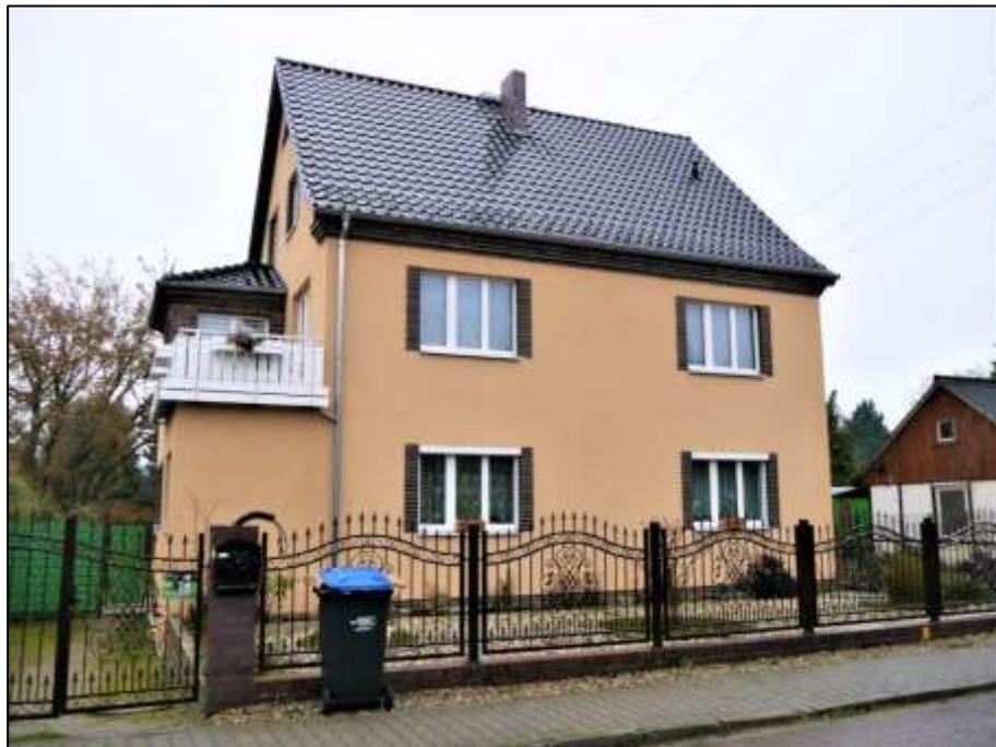
straßenseitige Front des auf dem Grundstück Alpenrosenweg 52 aufstehenden Wohngebäudes und unmittelbar hinter dem Bewertungsobjekt über dem im Bild rechten Nachbargrundstück verlaufender Hochspannungstrasse mit im Luftraumprofil verspannten Starkstromkabeln
