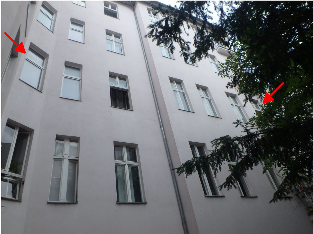
Wohn- und Geschäftshaus (Quergebäude) sowie Eigentumseinheit Nr. 14 Ostansicht (Hofansicht)
