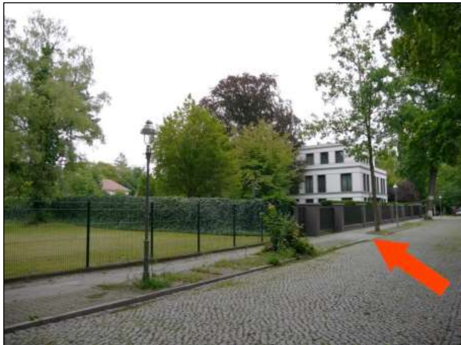
Blick aus dem Messelpark über die Bernadottestraße hinweg nach nach Osten mit Lage des Grundstücks Bernadottestraße 36 (Flurstück 12/7) auf der nord-östlichen bzw. im Bild linken Straßenseite (Pfeil)
