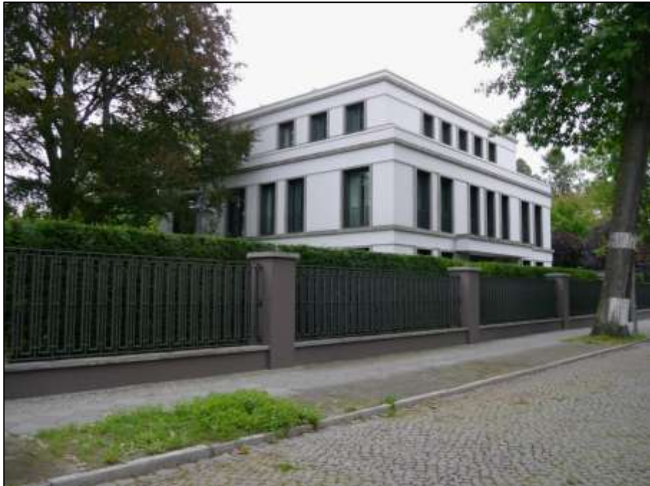
straßenseitige Front des Grundstücks Bernadottestraße 36 (Flurstück 12/7) im Vordergrund bis zum ersten Pfeiler und dahinter anbindende Straßenfront des süd-östlich angrenzenden Nachbargrundstücks Bernadottestr. 38 (Flurstück 284/12) mit durchlaufender Einfriedung
