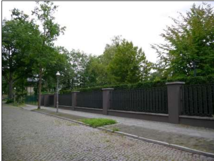
straßenseitige Front des Grundstücks Bernadottestraße 36 (Flurstück 12/7) und im Vordergrund über die ersten beiden Pfeiler des angrenzenden Nachbargrundstücks Bernadottestr. 38 (Flurstück 284/12)
