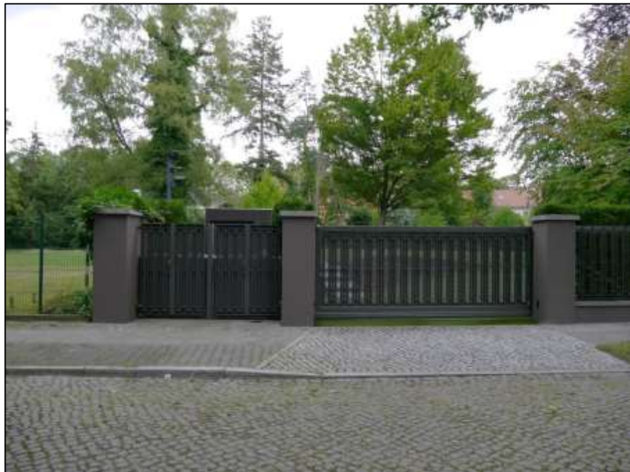
straßenseitige Front des Grundstücks Bernadottestraße 36 (Flurstück 12/7) im Bereich der westlichen Grundstücksecke mit freitragendem Hofschiebetor und links daneben Doppeltoranlage mit Schwenkflügeln im Charakter der weiteren straßenseitigen Einfriedung
