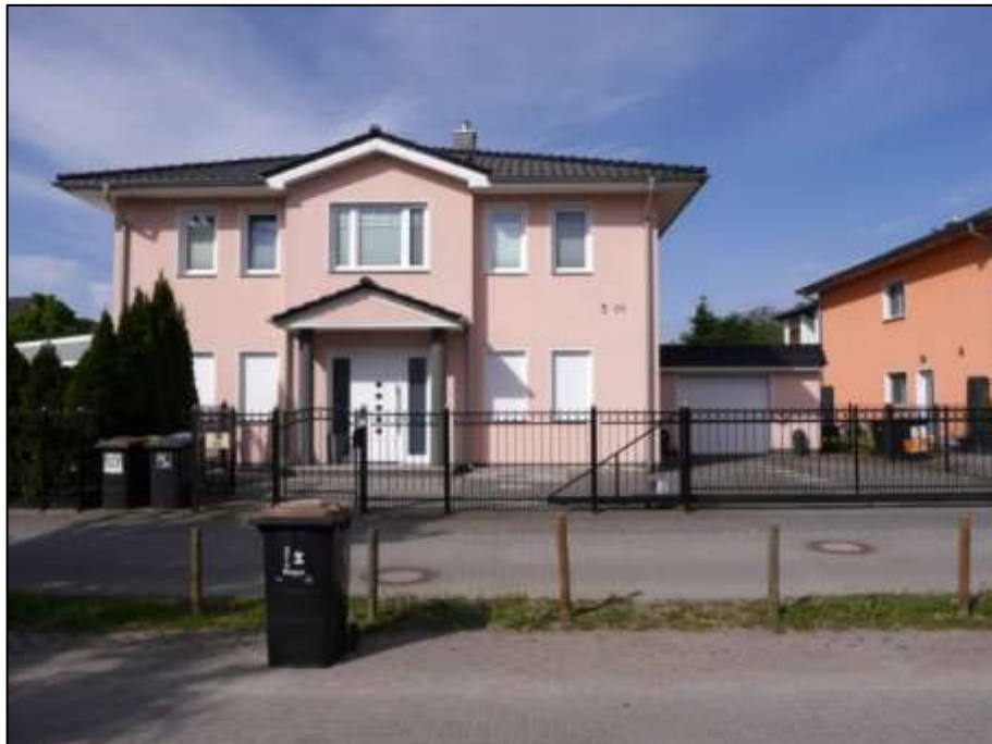
straßenseitige Front des auf dem Grundstück Seeadlerweg 69 aufstehenden Einfamilienhauses mit im rechten Bauwich belegendem Garagen-Anbau
