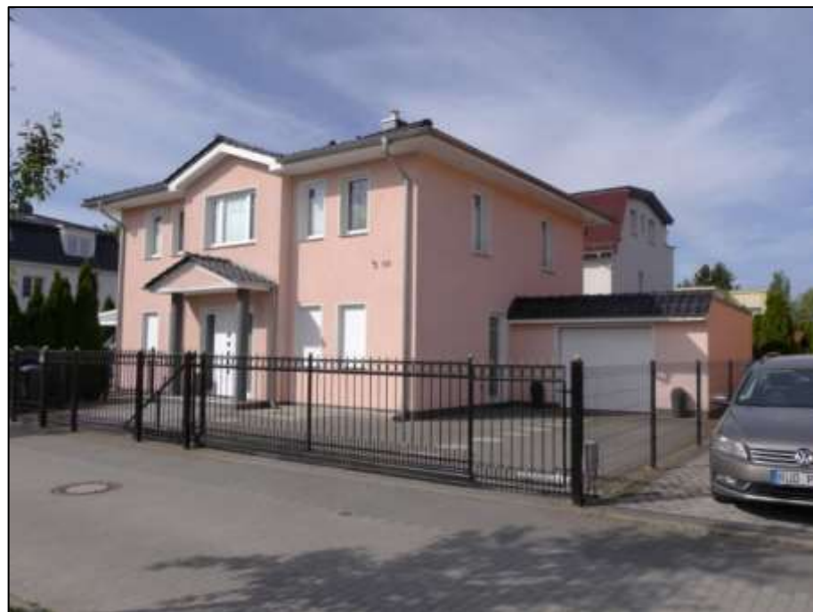
Blick aus dem Bereich des Seeadlerwegs nach Süd-Westen auf das Grundstück Seeadlerweg 68 mit aufstehendem Einfamilienhaus nebst Garagen-Anbau im rechten Bauwich
