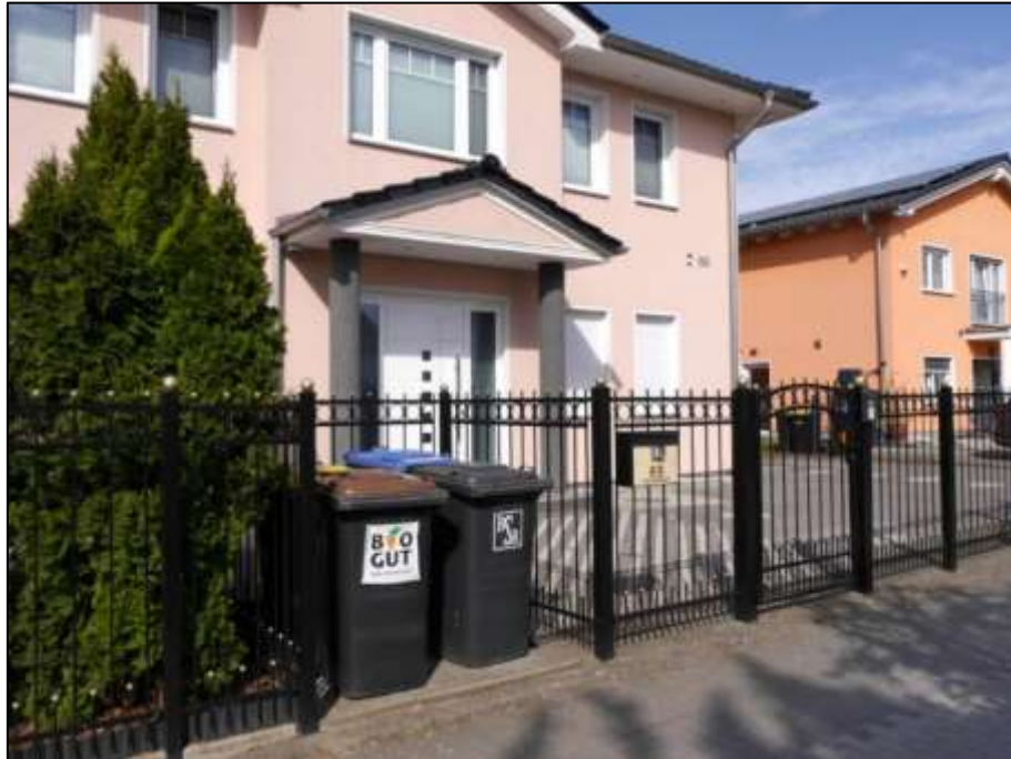
zum Seeadlerweg orientierte straßenseitige Einfriedung mit einkofferner Einfriedung als gleichfalls befestigte und frei zugängliche Müllgefäß-Stellplatznische
