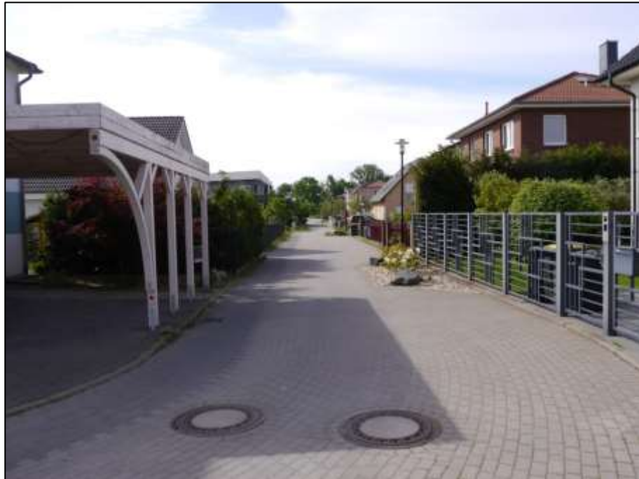
Blick in den Fischadlerweg aus dem Bereich der verschwenkten Streckenführung hinter dem Eulenweg nach Süd-Osten in den Grünflächenbereich des Siedlungsareals mit Wendehammer am Ende der Straße
